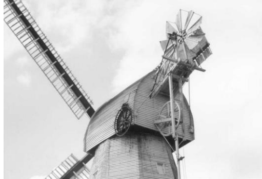
Fig.3 Il timone direzionale per i mulini a vento autoregolante
